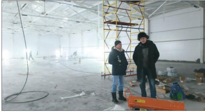
Именно с железобетонной технологической плиты, которая представляет собой многослойный пирог с несколькими уровнями теплоизоляции и верхним слоем, прошитым трассами с хладагентом, и начинается лёд.
